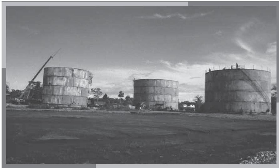
Construcción de Tanques de Maxus, 1990. Foto Hugo Rengifo
